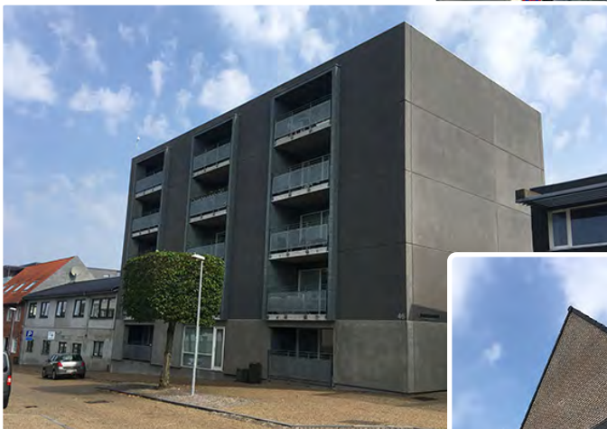
Nyere etageboliger ved Strøget
