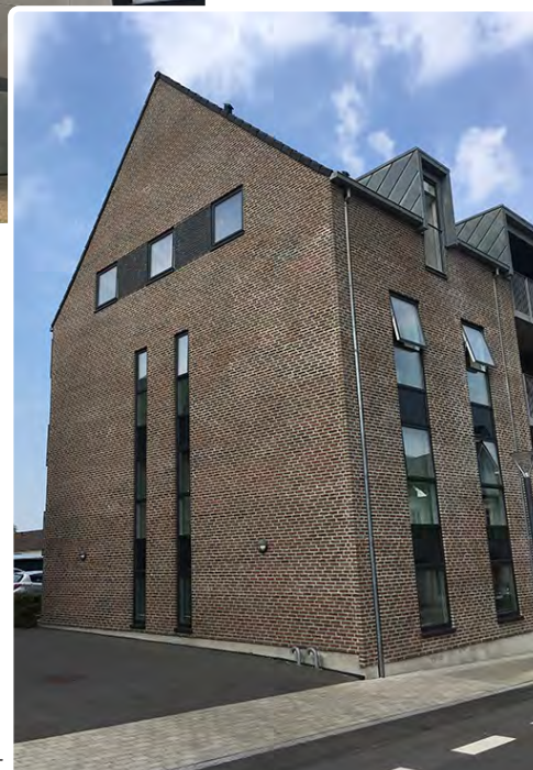
Nyere etageboliger ved Strøget
