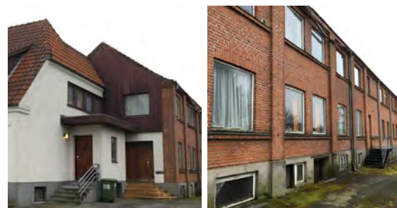
Større baghusfabrik, Villavej 27
