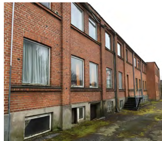
Den ældste del af fabrikken, 2017
