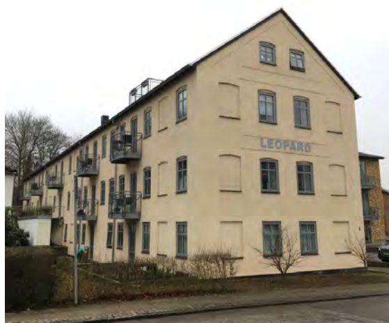
Den typisk fabriksgavl, Tulstrupvej 5
